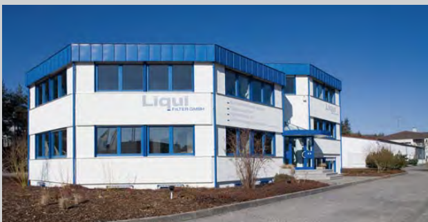
Liqui-Filter GmbH Verwaltung und Produktion in Engen
