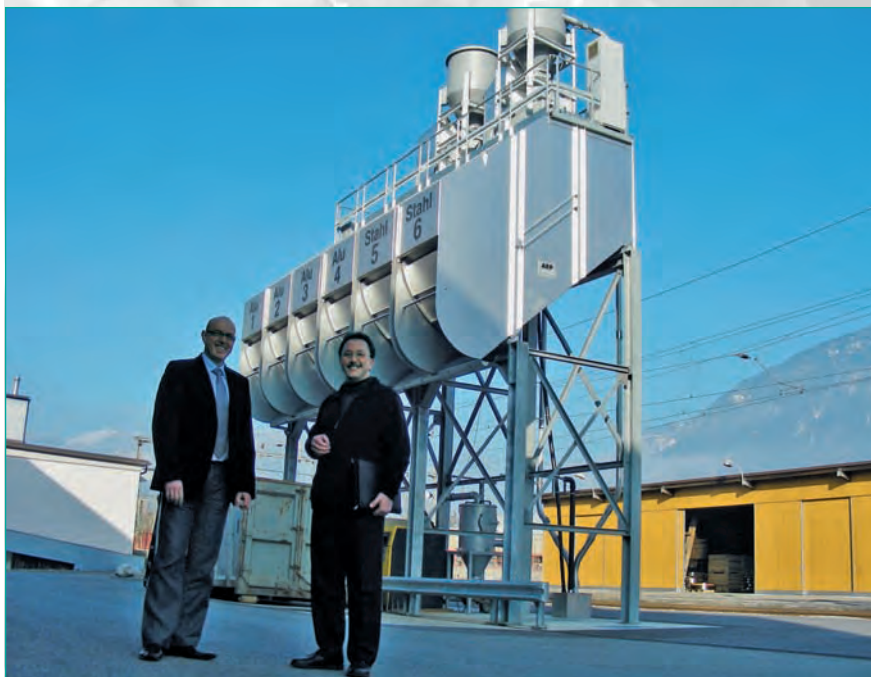
Endstation für den Abtransport mit Lastwagen: Jede der 6 Silokammern fasst maximal 10 m 3 Späne. Hier werden die Späne fein säuberlich in den Silokammern getrennt gelagert. Im Bild Markus Havrda (links), Leiter Mechanical Engineering bei Ruag Components, und Gustav Fricker, Geschäftsführer Helfina.
